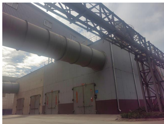
1#矿棉生产线矿棉板除尘器
