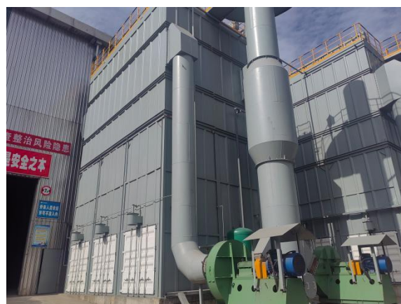
2#矿棉生产线输棉工序 2 台除尘器
