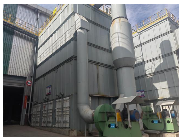
1#矿棉生产线输棉工序 2 台除尘器
