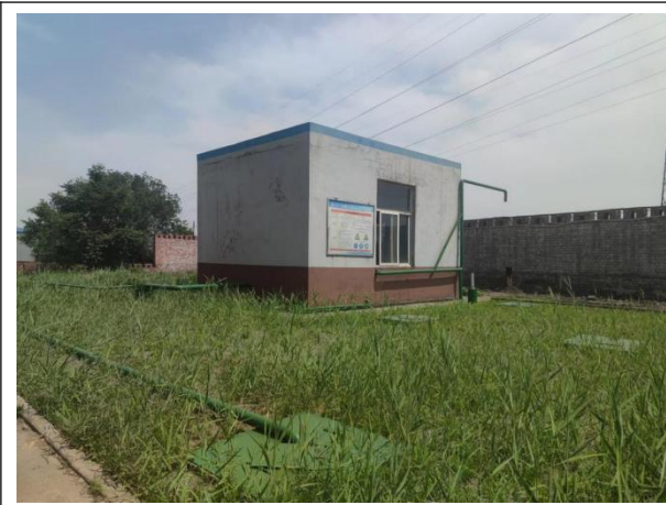
义望铁合金公司生活污水处理站
