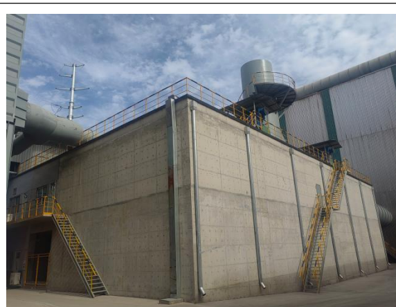
2#矿棉生产线矿棉板除尘器
